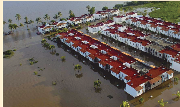
Imagen 3: Vista aérea de un desarrollo habitacional en Acapulco, Guerrero, después del paso del huracán Manuel en el 2013. Fuente: http://www.hechosdehoy.com/emergencia-en-sinaloa-con-el-huracan-manuel-y-golpe-a-acapulco-30276.htm
