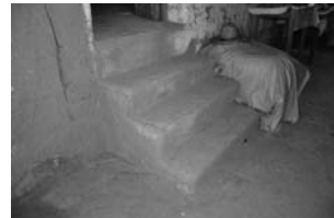
Escalera acceso cuarto redondo
