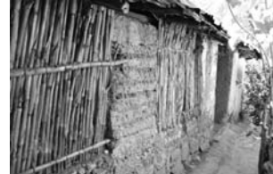
Los vanos de columnas del pórtico cubiertos (dormitorio)
