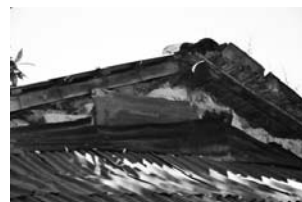
Cubierta de lámina de cartón, teja y lámina zinc
