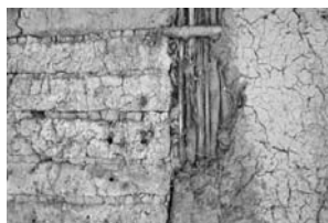
Muro de adobe y bajareque
