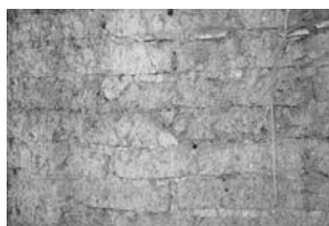
Muro de adobe de 40 x 60 cms
