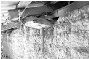
Anclaje de viga principal para curbierta
