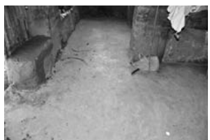
Piso de concreto simple al interior de la cocina-comedor
