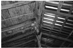
Detalle interior de cubierta en vivienda
