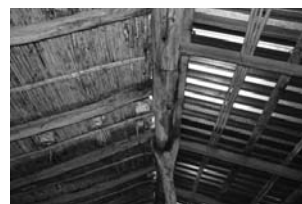
Cubierta del pórtico de lámina de cartón
