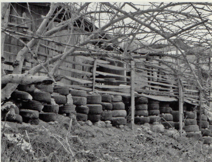
Foto 13 VIVIENDA PRECARIA Y EN RIESGO, EN CHILPANCINGO
