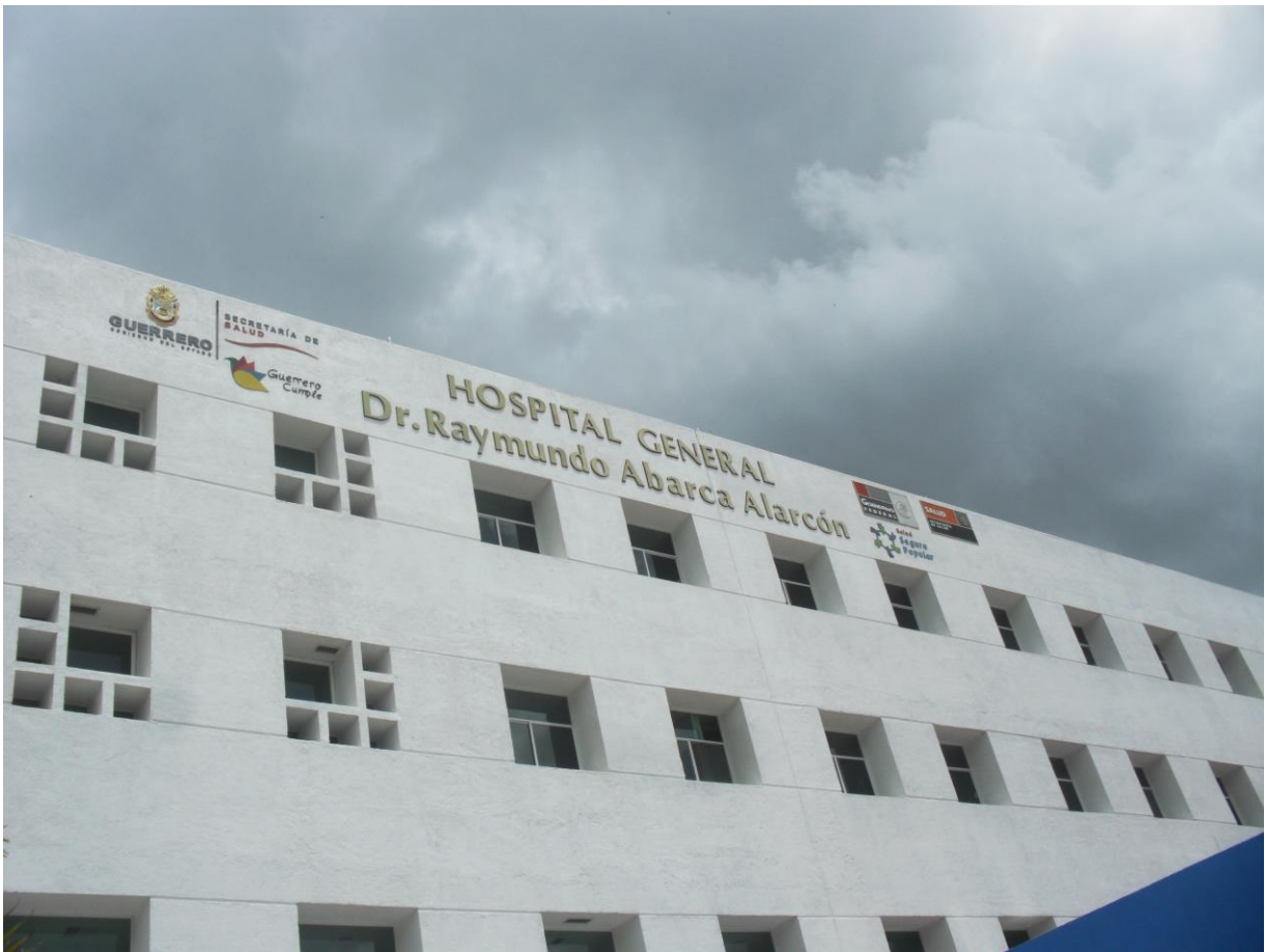
4.28 . Vista Relación Vano-Macizo en fachada del edificio principal del Hospital General de Chilpancingo. Fuente: Archivo personal (2015).
