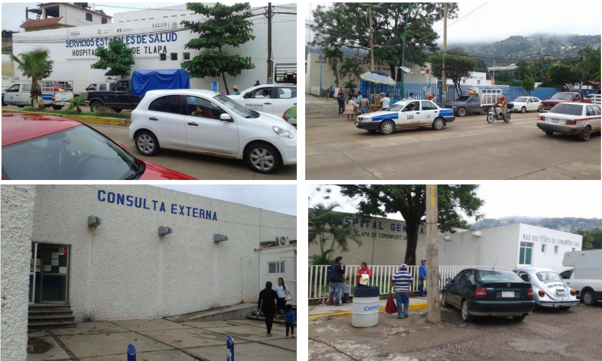
4.29, 4.30, 4.31 y 4.32 . Vista del Exterior del Hospital General de Tlapa. Fuente: Archivo personal (2015).
