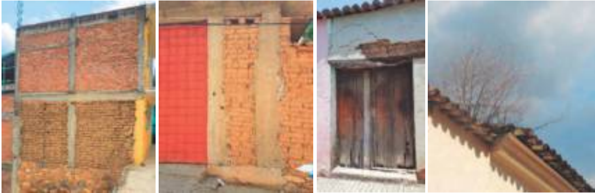
Ilustración 22. Ejemplos de las afectaciones presentes en la vivienda vernácula del sitio. Fuente: El autor
