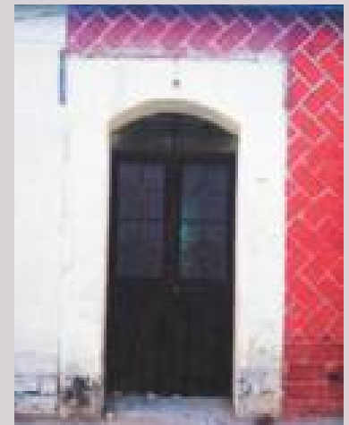
Detalle de vano correspondiente a la entrada principal, se observa el remate superior con arco rebajado y la puerta de herrería. Fuente: Adame, Alarcón & Lanche (2013)
