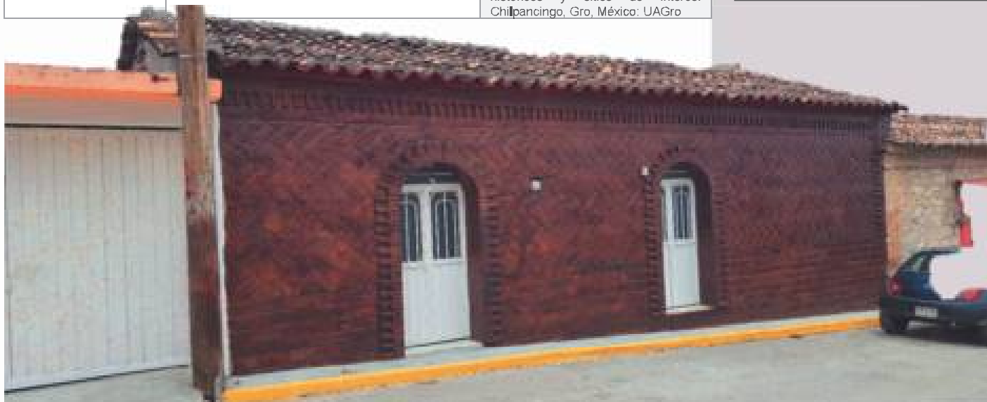
Fachada principal de la Vivienda fotografía tomada por el autor. Visita realizada en el 2017.
