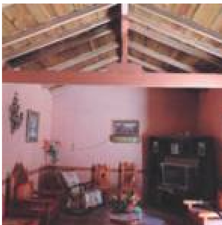
Fotografía del interior de la vivienda, se aprecia la estructura soportante del techado y el entablado. Visita realizada en el 2017.
