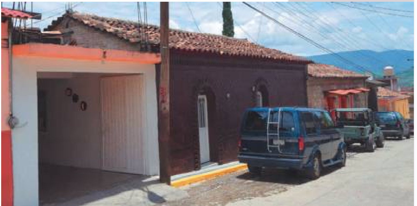
Fachada principal de la Vivienda y la integración con el contexto fotografía tomada por el autor. Visita realizada en el 2017.
