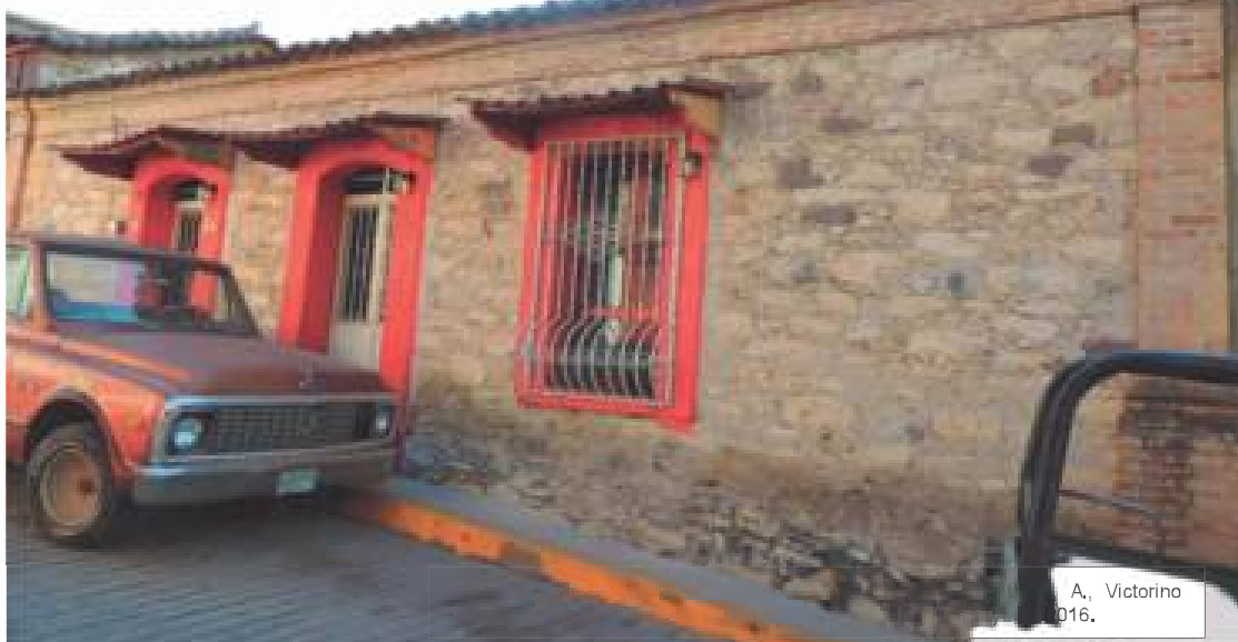
Detalle de vano correspondiente a un balcón, se observa el remate superior con arco rebajado y la reja de herrería. Fuente: Adame, Alarcón & Lanche (2013)
