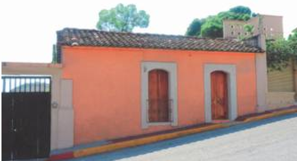
Fachada principal de la Vivienda fotografía tomada por el autor. Visita realizada en el 2017.
