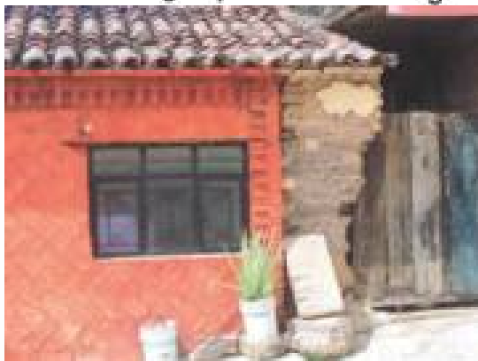
Detalle de los vanos, estado actual, fotografía tomada por el autor. Visita realizada en el 2017.
