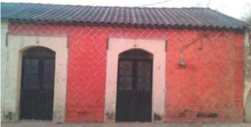
Muro cubierto con enladrillado colocado en petatillo (a 45°). Con rodapié igual enladrillado pero colocado en tipo muro capuchino. Fuente: Adame, Alarcón & Lanche (2013)
