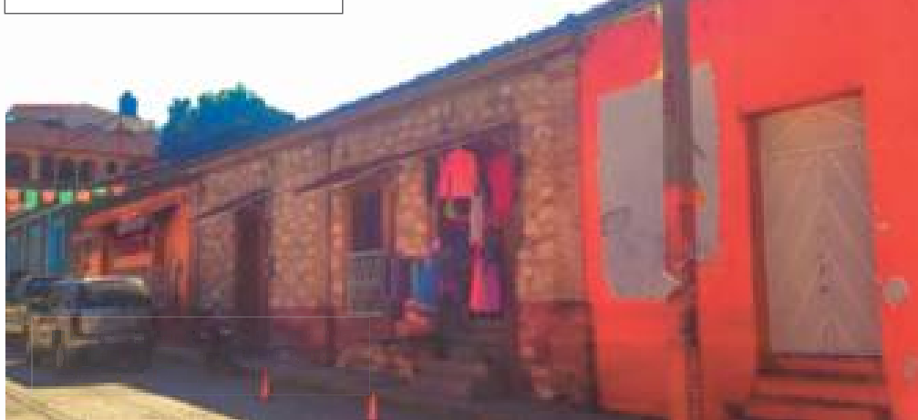
Fachada principal de la Vivienda fotografía tomada por el autor. Visita realizada en el 2017.
