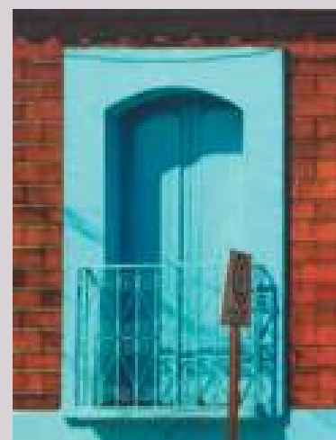
Detalle de vano correspondiente a un balcón, se observa el remate superior con arco rebajado y la reja de herrería. Fuente: Adame, Alarcón & Lanche (2013)
