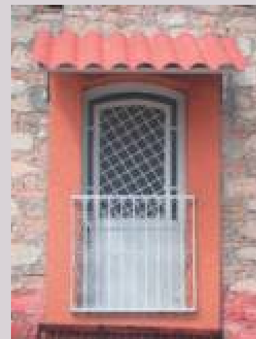
Detalle de vano correspondiente a un balcón, se observa el remate superior con arco rebajado y la reja de herrería. Fuente: Adame, Alarcón & Lanche (2013)
