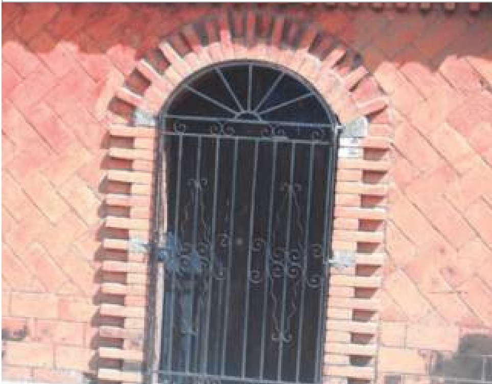
Enladrillado en Fachada se aprecia el remate de vanos, el muro capuchino en el rodapié y el colocado tipo petatillo en el resto del muro el cual es rematado por una cornisa igualmente de ladrillo
