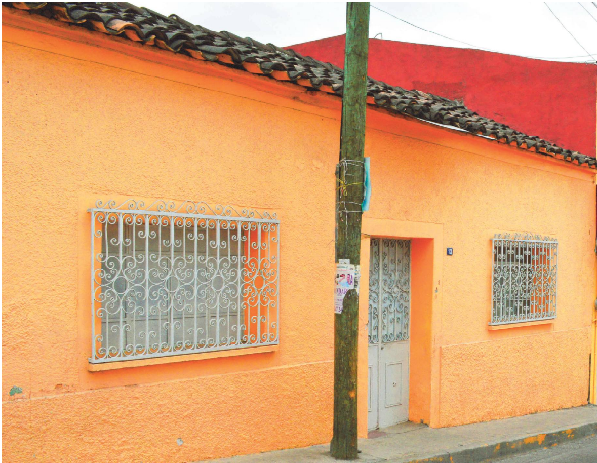
Figura 20. Imagen de una vivienda tradicional del barrio de San Mateo. Fuente propia. Chilpancingo; Gro. 2015
