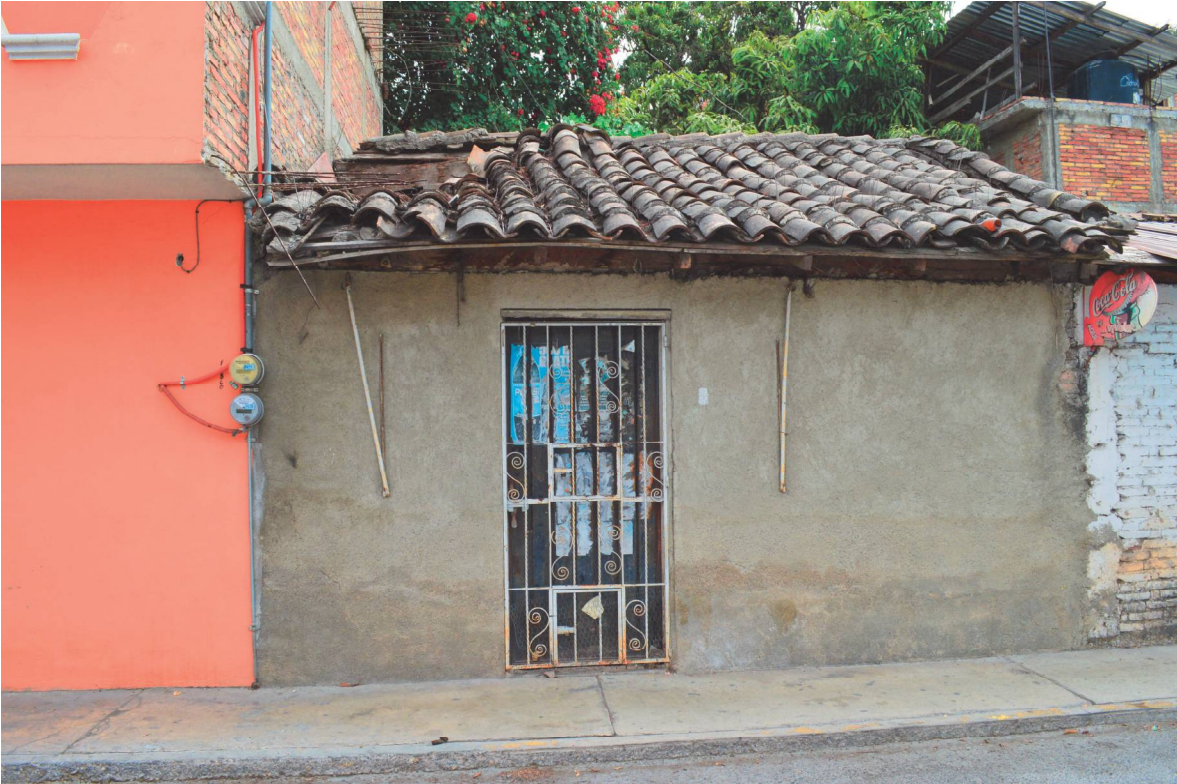
Figura 21. Imagen de una vivienda tradicional del barrio de San Mateo. Fuente propia. Chilpancingo; Gro. 2015
