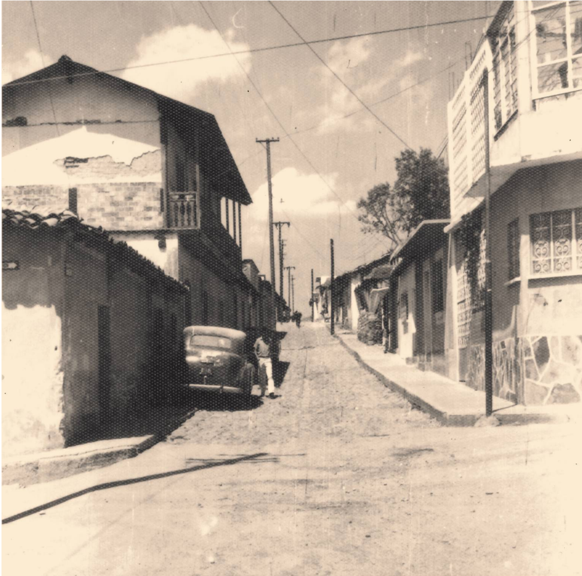
Figura 47. Imagen de la calle Cuauhtémoc Esq. con calle Corregidora perteneciente al barrio de San Mateo Fuente Sergio Adame Archivo personal. Chilpancingo; Gro. 2015
