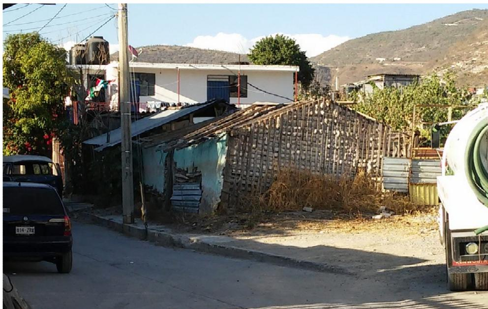
**Imagen 36. Vivienda afectada en condición precaria con muros de bahareque y techo de lámina, quedó inhabitable por los daños**
