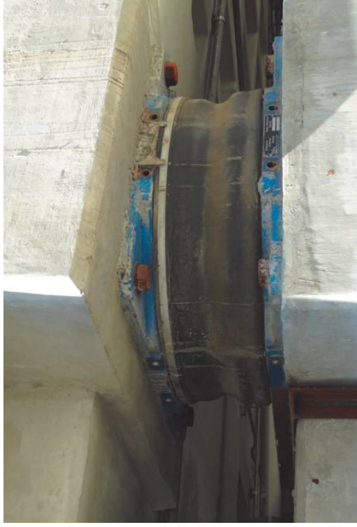
Fotografía # 26. Aisladores sísmicos Fuente. D. Adame Arcos 2015
