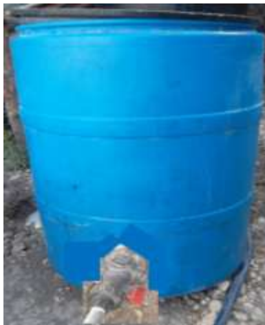
Imagen 11.- Colector de las primeras aguas de lluvia de la temporada.
