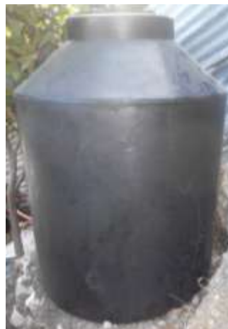
Imagen 13.- Depósito para almacenar el agua de lluvia, para su uso posterior.
