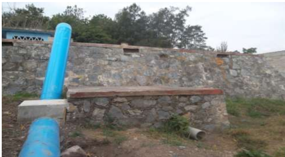
Imagen 6.- Tanque de Almacenamiento Peña Rajada
