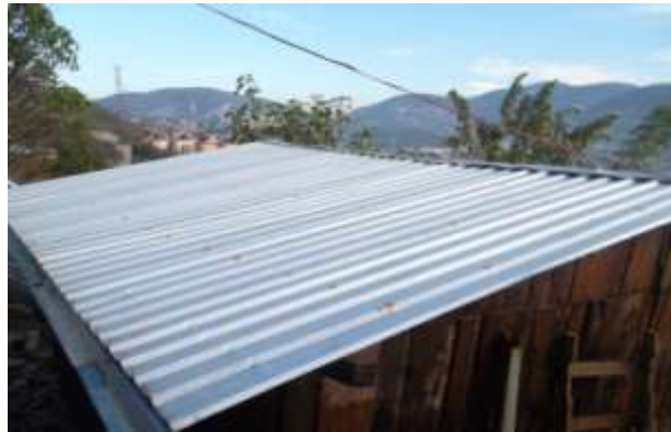
Imagen 9.- Área de captación de la vivienda popular en la colonia Plan de Ayala Fuente: propia.
