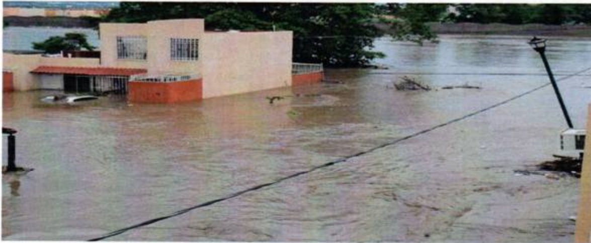
Foto: inundaciones en Quinta Miramar, ubicadas en Nicolás Bravo S/N Col. Quintas Miramar, Llano Largo.
