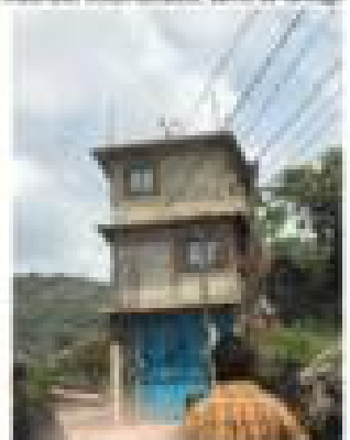
Vivienda de block, Barrio de San Juan
