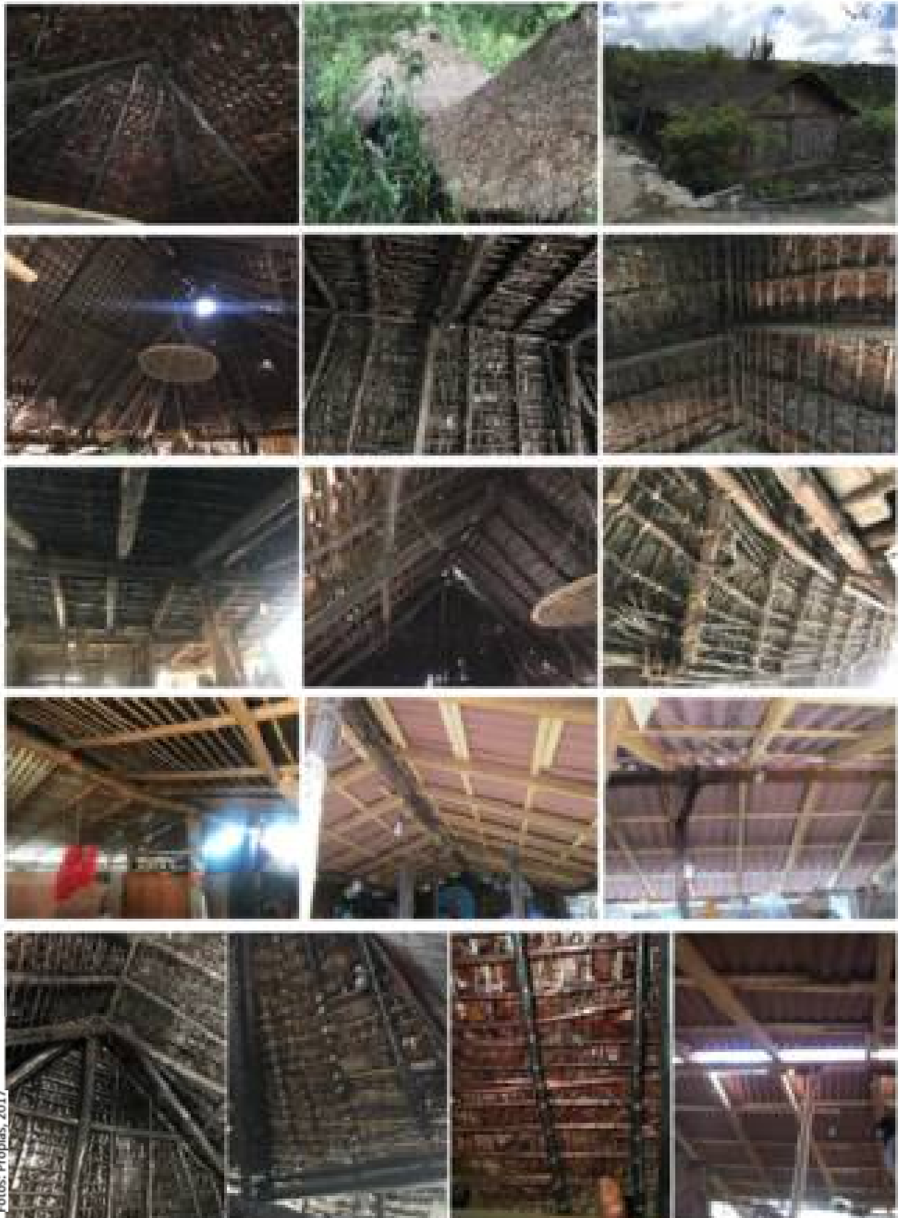
Foto 94 En el interior la palma se amarra con la misma palma, la estructura es de cedro blanco, y para la lamina ya va sujeta con tornillos, clavos y es madera de pino la estructura.
