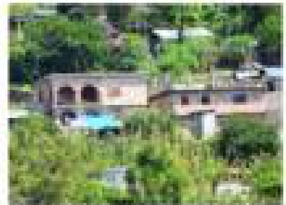
Viviendas de mampostería industrializada, Barrio de San Juan
