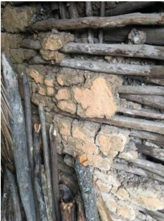
Foto 72 detalle constructivo, propia 2017
