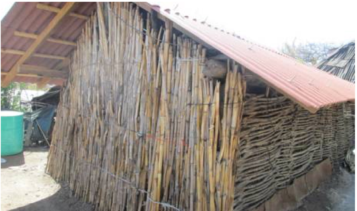
54 Foto, vivienda de ahuasol y bajareque con techo de lámina de ferrocemento
