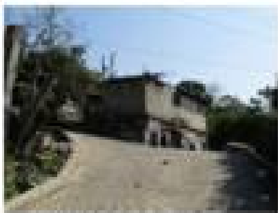
Vivienda de block, Barrio de San Juan
