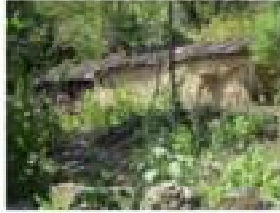
Vivienda piedra de frangula, Barrio de San Juan
