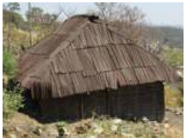
Foto 31 vivienda de techo de lámina y muros de bajareque, propia 2017
