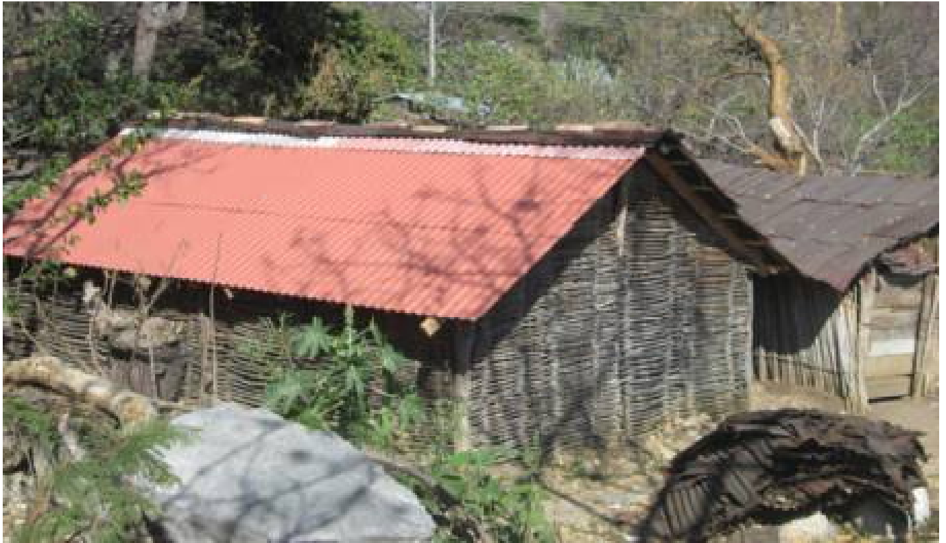
56 Foto de vivienda de bajareque con lámina de ferrocemento.
