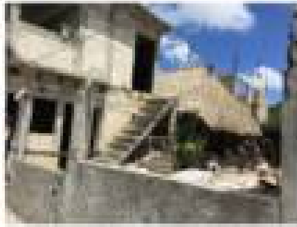
Vivienda con mezcla de adobe y concreto, Barrio de San Juan
