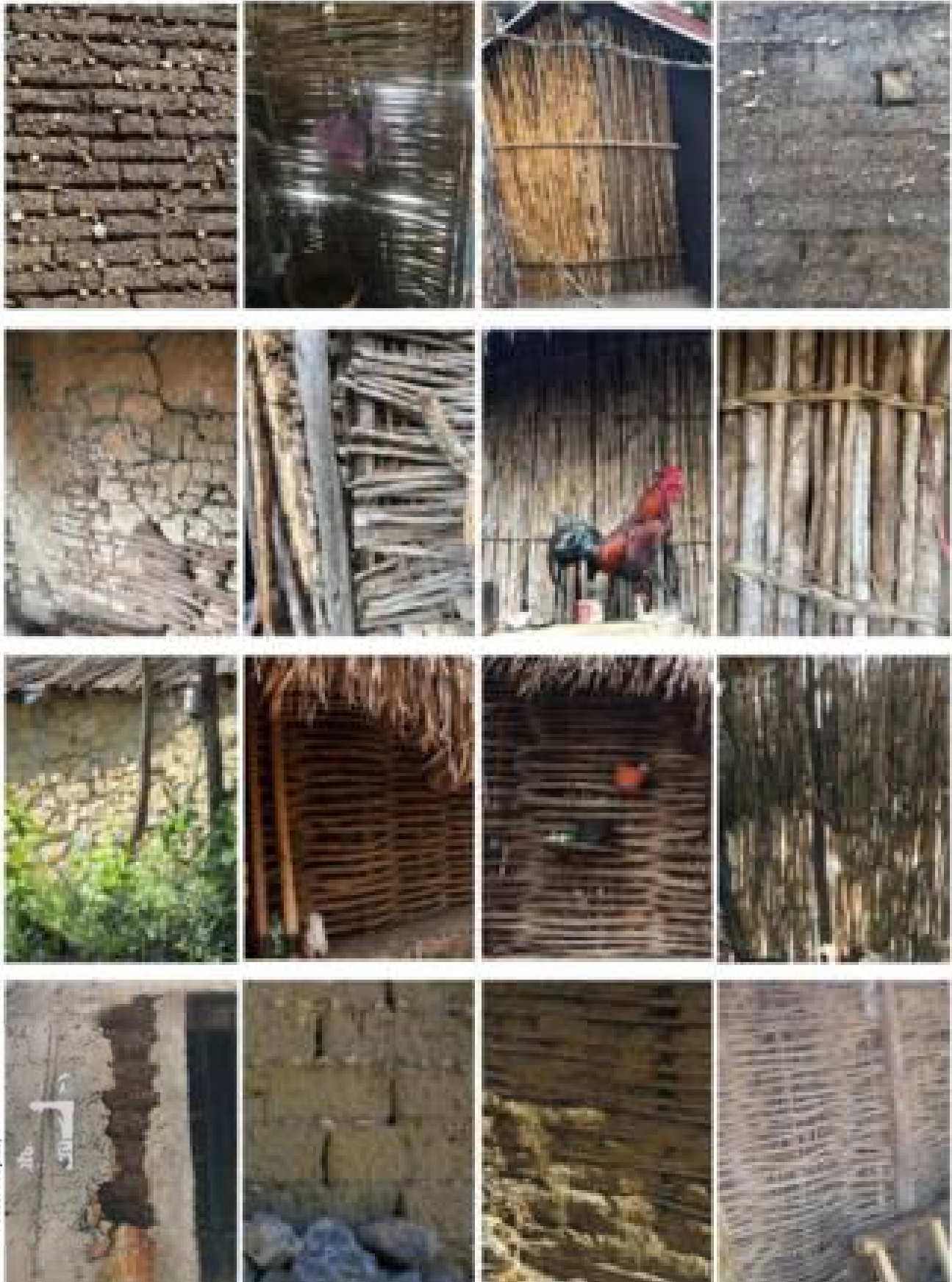
Foto 92 los materiales más utilizados para los muros son la vara de cedro blanco tejida para hacer el bajareque, en algunos casos revocada de adobe, el adobe revcado con concreto, de piedra, ahuasol y acahual
