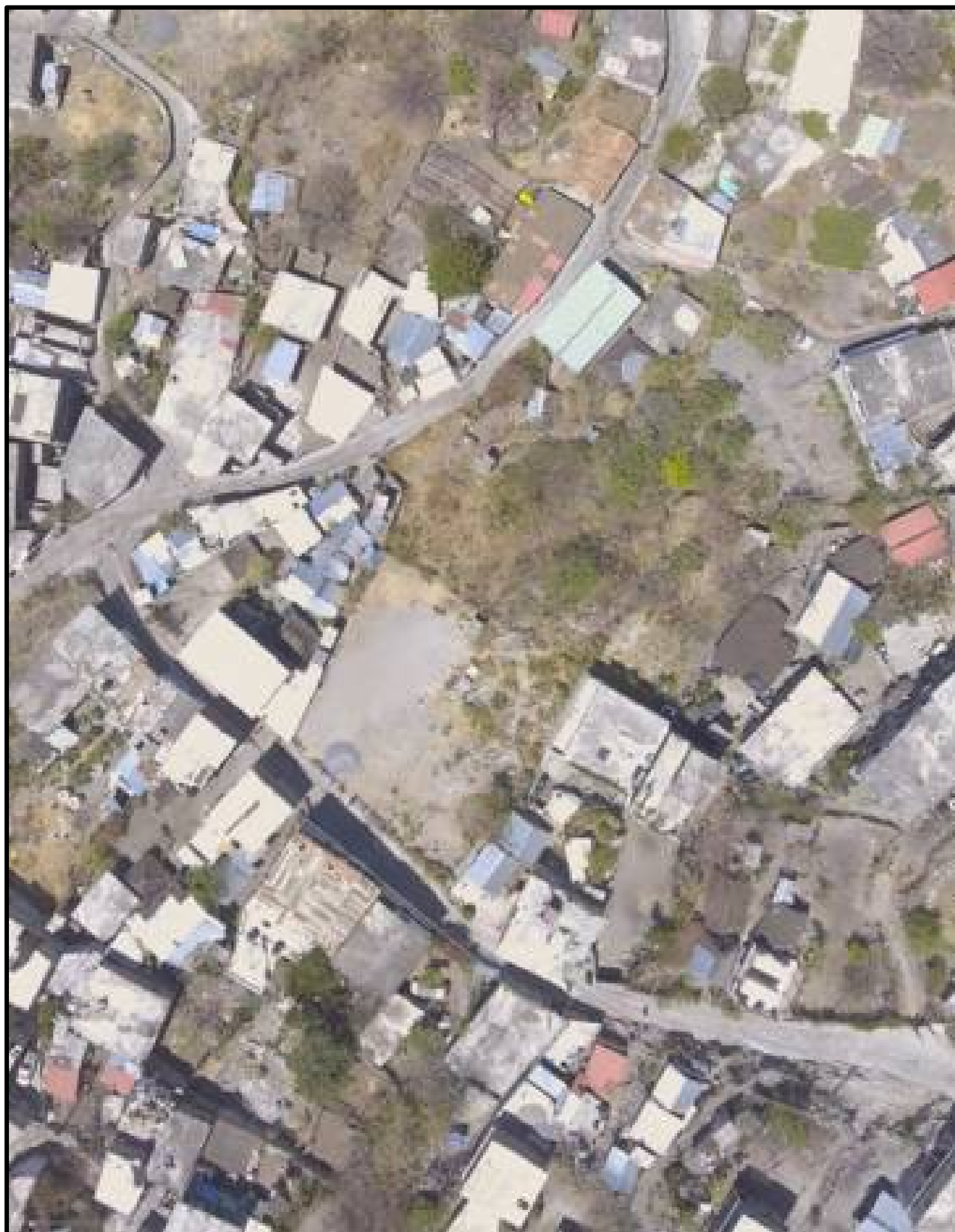
Foto 27 Barrio de Santiago donde se observan las viviendas de techo de losa y las de techo de palma, drone 2017
