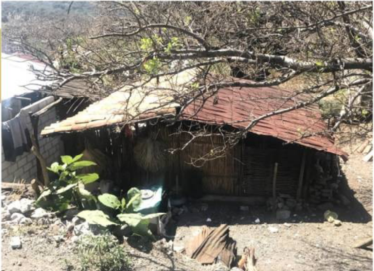
76 Cocina de bajareque y ahuasol, con techo de ferro cemento.
