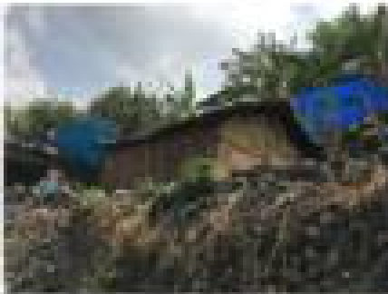
Vivienda de Ahuacal y Ahuacal, Barrio de Santiago
