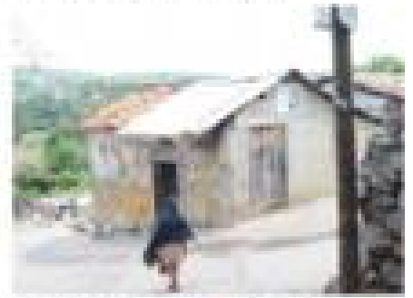
Vivienda de adobe, techo con concreto, Barrio de San Juan
