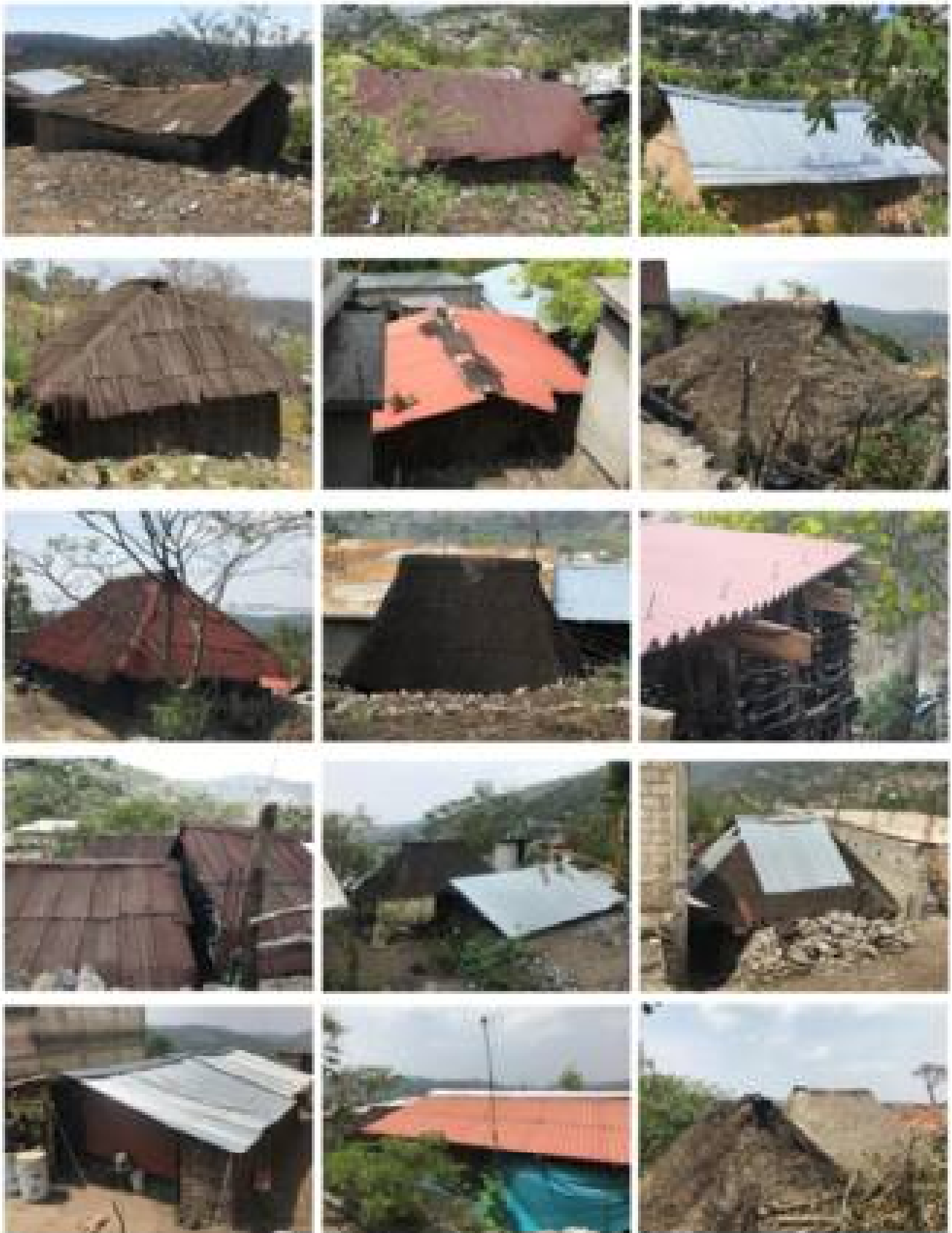
Foto 93 El materiales utilizado para los techos es de lámina de cartón, galvanizada o palma.
