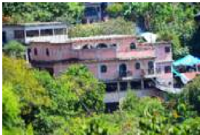
Foto 88 Transformación de vivienda, propia 2017
