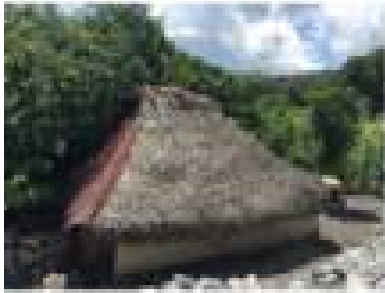
Vivienda de adobe, techo a baseanaco, fachada con barro de Santiago
