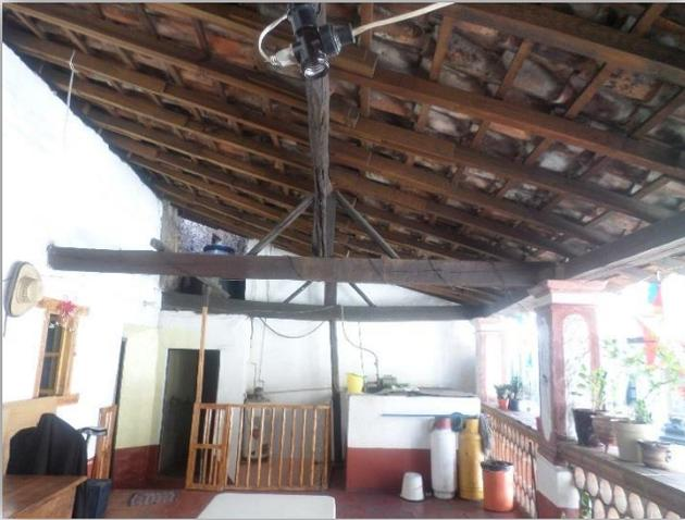
Imagen: 030 utilización de vigas de madera en techo, y teja.
